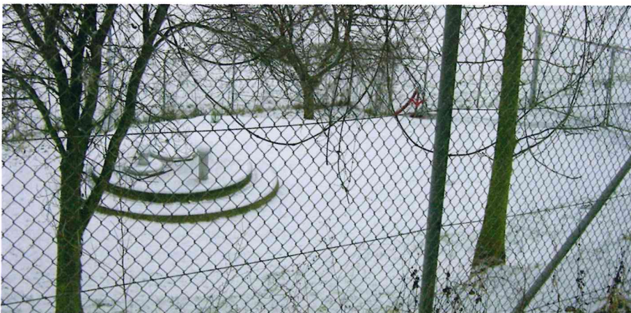
Abb. 1: Typische Einzäunung der Schutzzone I um einen Brunnen einer gemeindlichen Wasserversorgung © Treskatis
