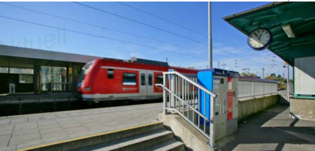
Bahnverkehr als eine Lärmquelle
